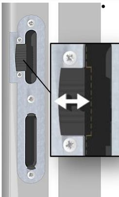
**stumpf:** Das Schließblech ist mit einer geräuschkindernden Kunststoffschließecke versehen, welche nach dem Lösen der beiden Schrauben verstellt werden kann.
